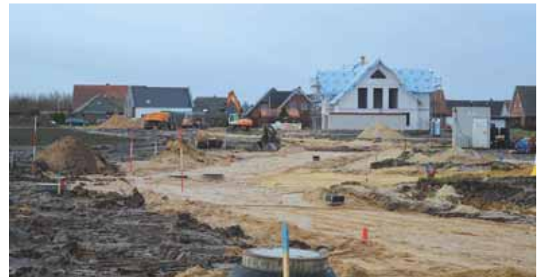
Während im Baugebiet „Vor den Lehmkuhlen“ in Wrestedt die Baustraße errichtet wird, entsteht schon das erste Wohnhaus. Foto: Lüchow
