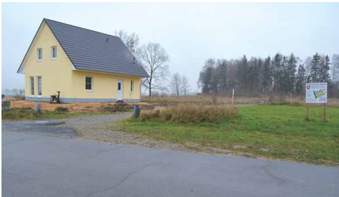
Im Suhldorfer Neubaugebiet „Wilhelm-Beindorf-Weg“ ist das erste Haus bereits fertiggestellt.
