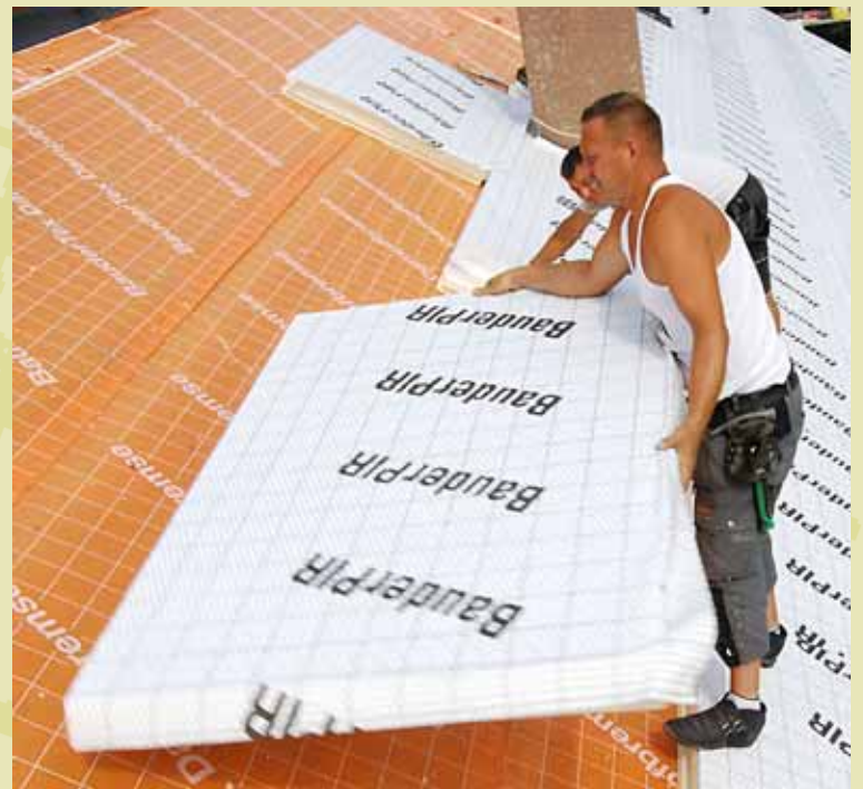
Ein lückenloser Dämmaufbau bietet langfristigen Schutz. Fotos: djd/Paul Bauder
