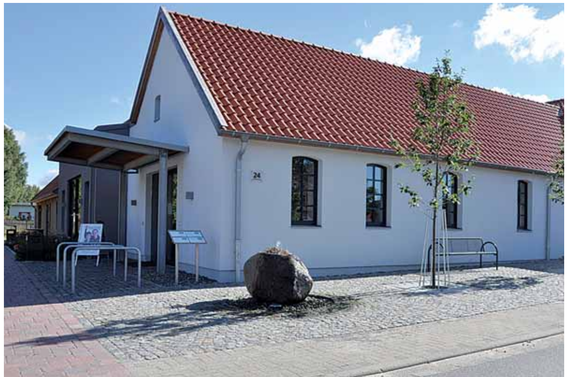
Alte Schmiede in neuem Glanz: Das heutige Gemeindehaus wurde aufwendig saniert.
