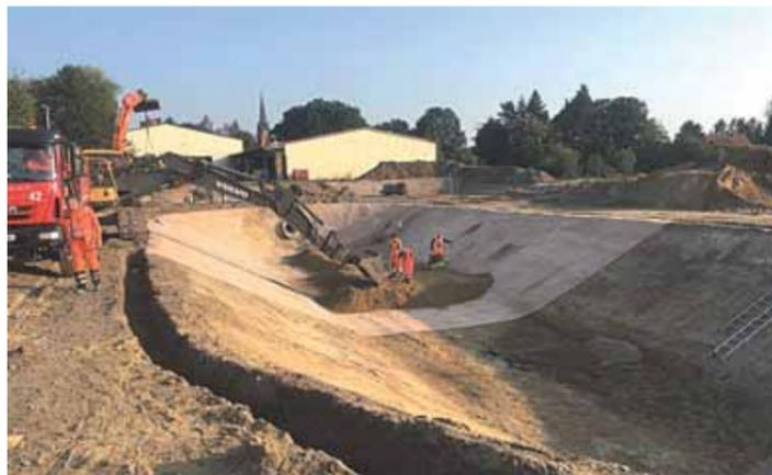
Mit dem Bau des Regenrückhaltebeckens wurde bereits begonnen.
