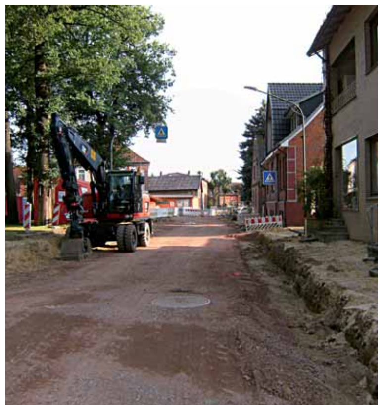
Trotz schwieriger Bodenverhältnisse und häufiger Grundwasserprobleme liegen die Bauarbeiten in der Ortsdurchfahrt voll im Zeitplan.
