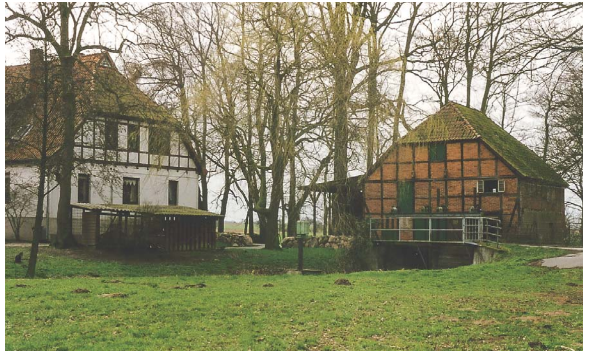
Das Mühlengebäude der Oetzmühle (r.).
