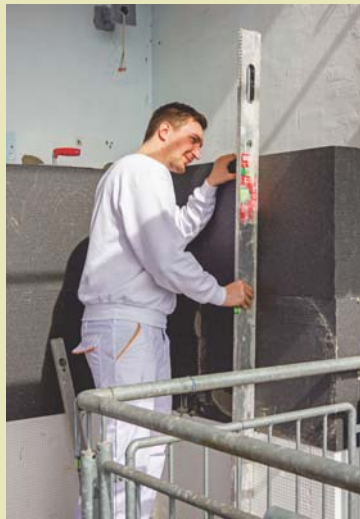
Die Dämmung ist einer der wichtigsten Schritte zu mehr Energieeffizienz. Foto: djd/IVH/Felix Scholz
