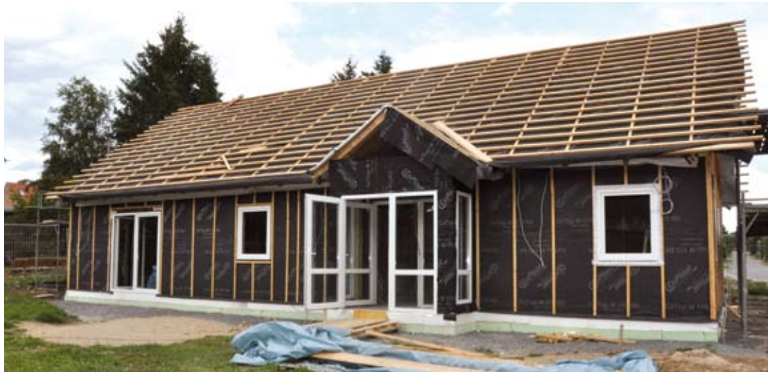
Die neue Kinderkrippe in der Ringstraße in Rosche-Prielip während der Bauphase
