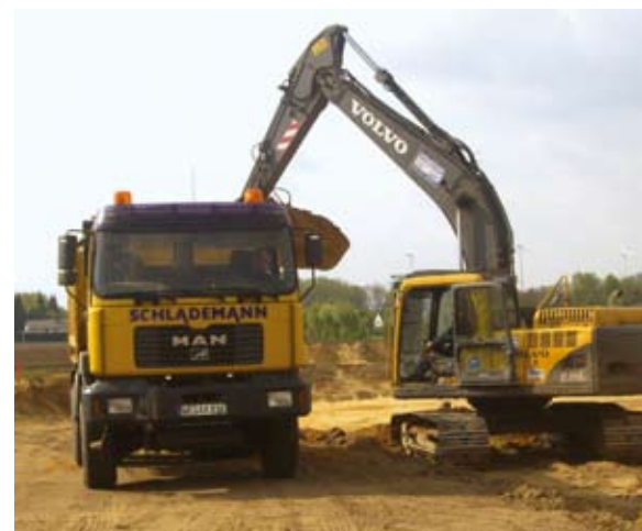
Gut gerüstet für Erdarbeiten aller Art
