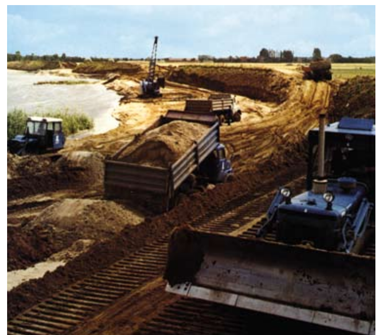
Typisch für Heinz Licht Baustellen: die stahlblauen Fahrzeuge sind allgegenwärtig. Hier bei der Verstärkung des Elbdeiches in Drennhausen-Laffrönne (LK Winsen) in den 1970er Jahren Foto: Siegmund/Sig. W. Ibkendanz
