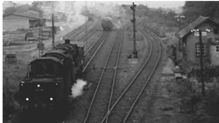
Die Vielzahl der Gleise, die noch 1966 in Schnega zu finden waren, zeigt, wie geschäftig der Bahnhof angefahren wurde. Fotos (2): wendland-archiv.de
